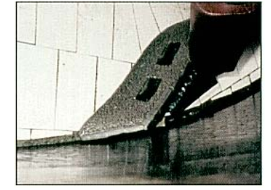
Malaxeur béton, racleur
