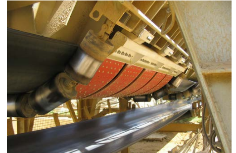
Cement, 800 T/uur. Transportband 1200 mm (5 hangende Flexal banden)
