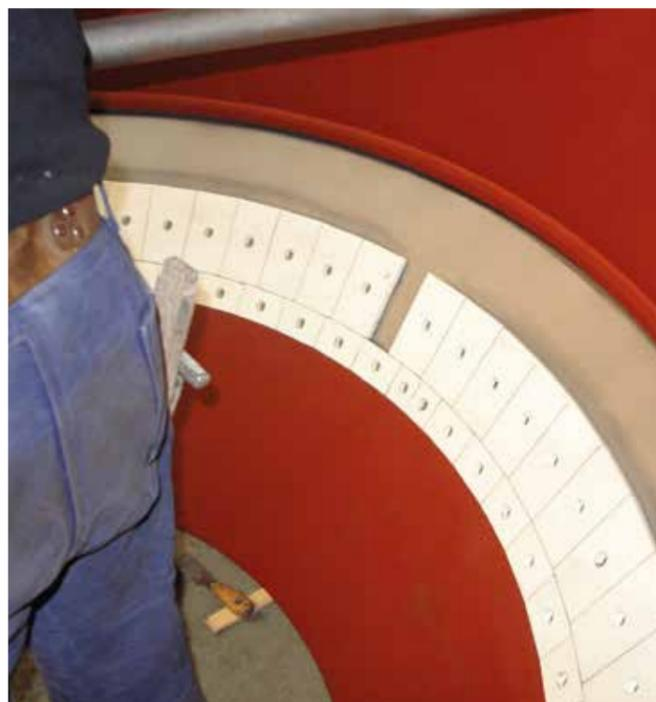
On appelle céramique à base d'oxyde d'aluminium les matériaux céramiques ayant une teneur en  $Al_2O_3$  de plus de 80 % (pour une protection optimale contre l'usure, seule la céramique ayant une teneur minimale de 92 % d' $Al_2O_3$  doit être utilisée).
