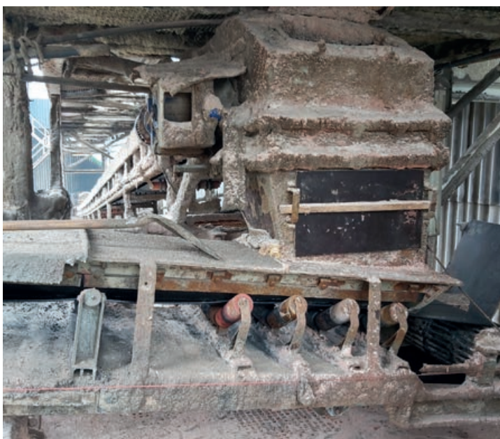
Afb. 3 Een morsende transportlijn vervult de werkvloer
